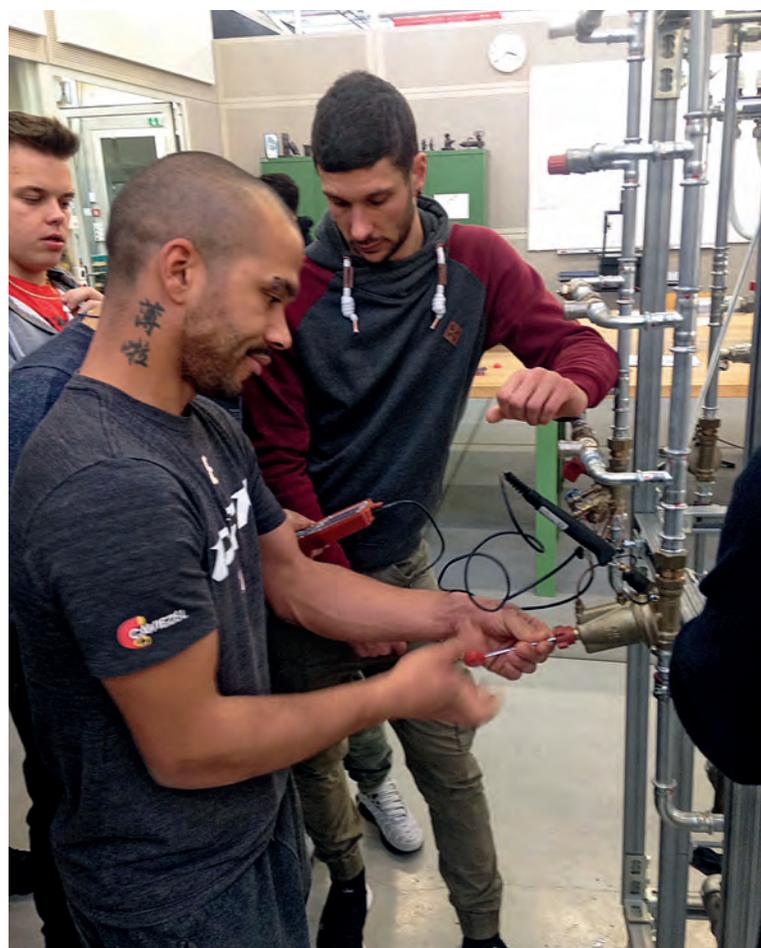
In queste immagini i nostri allievi stanno misurando il bilanciamento idraulico dell'impianto di riscaldamento.
