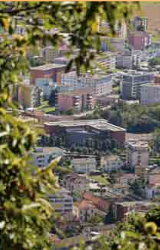
In copertina: il Centro professionale di Locarno visto dai Monti (foto Claudio Zaninetti)
