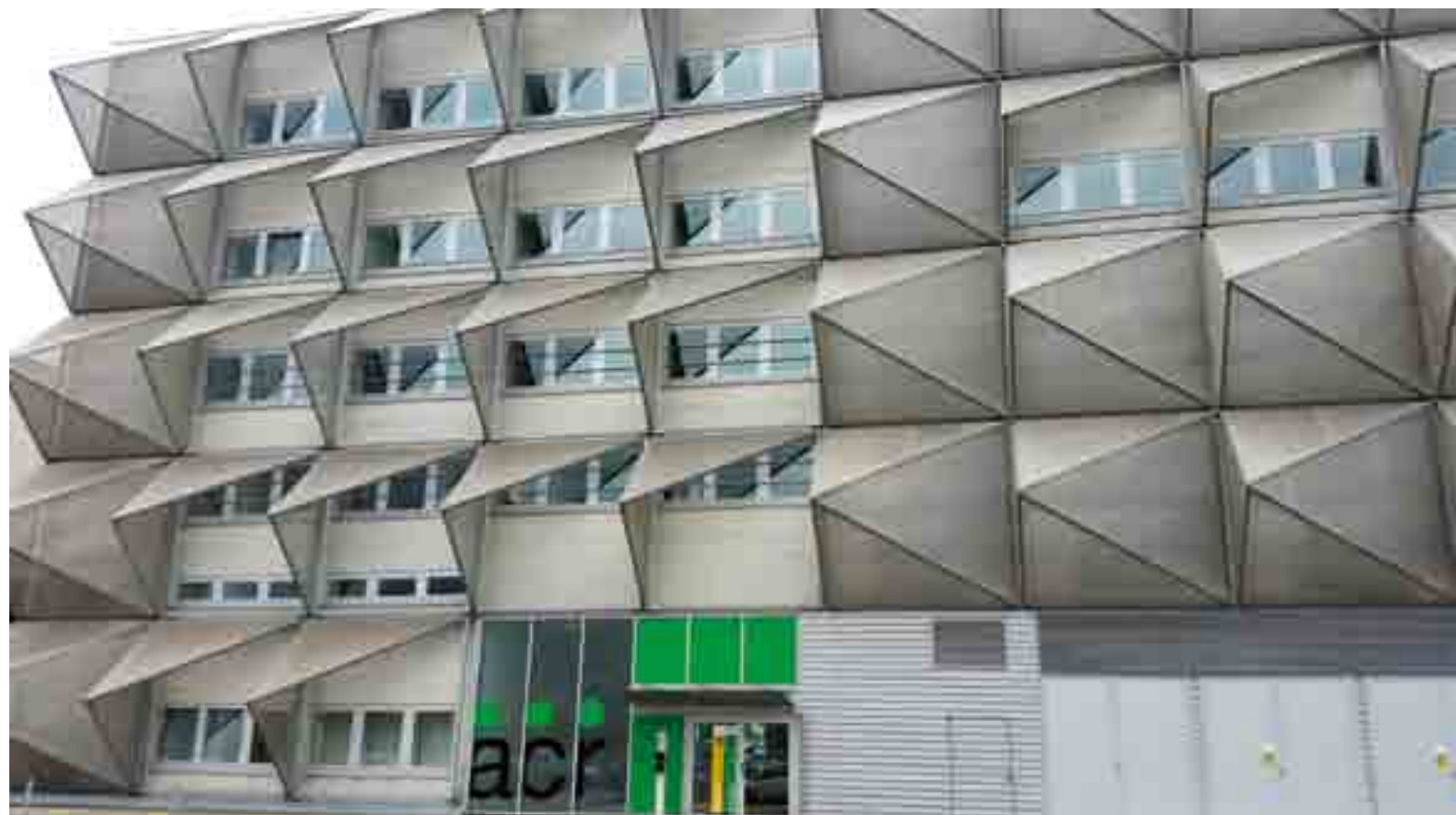
L'impianto cantonale di termovalorizzazione dei rifiuti di Giubiasco è in funzione tutti i giorni, 24 ore su 24: la combustione dei rifiuti (a destra) alimenta un sistema di teleriscaldamento ecologico.
